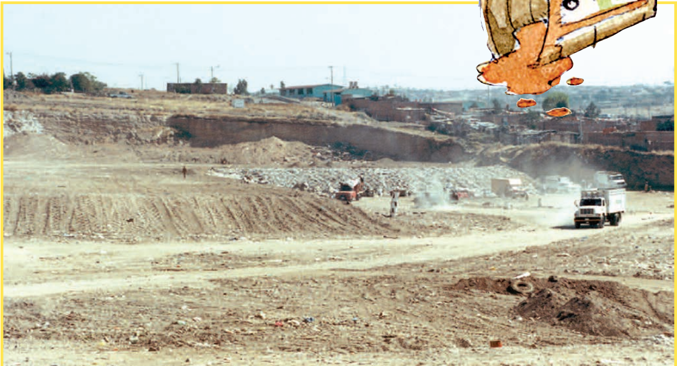
Relleno sanitario en Aguascalientes.
